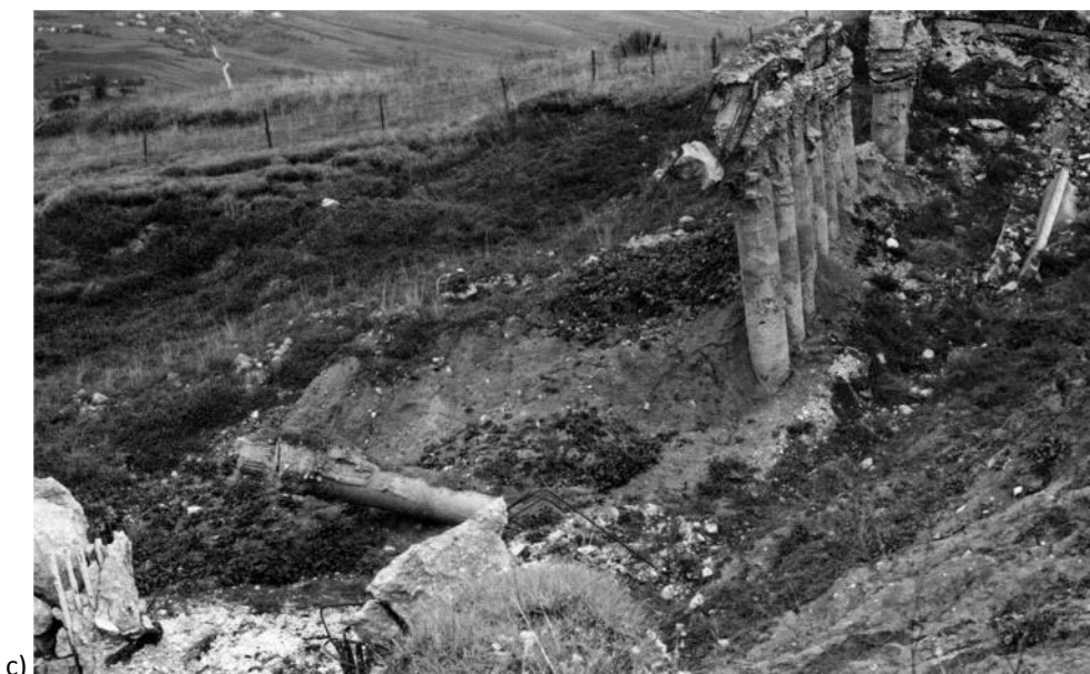
Fig. 10 – Esempio di deformazioni in atto su alcune aree del territorio comunale: a) movimento franoso di tipo misto (scorrimenti + colamenti) in loc. Perillo; b) interpretazione delle complesse deformazioni a carico dello stesso versante; c) rilevanti danni a carico di una palificazione profonda.
